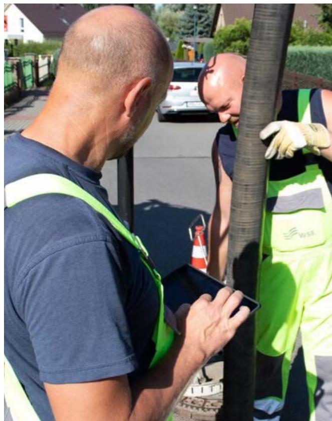
Bild 2: Direkt vor Ort können über die App relevante Daten zum Versorgungsnetz eingegeben werden.
