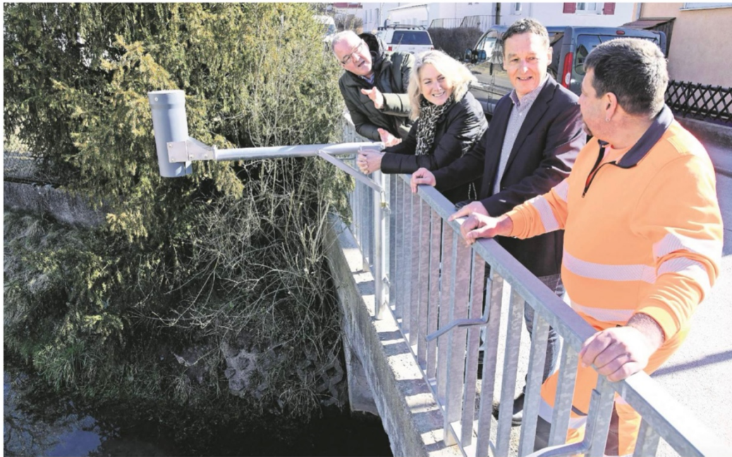
Nehmen die Hochwassersensoren beim Radar-Pegel am Käsbach an der Oberen Straße in Entringen in Betrieb (von links): Edmund Berg (edberg kommunal), Bürgermeisterin Christel Halm, Thomas Trettel (Fa. tablano) und Bauhofleiter Alexander Zader.
